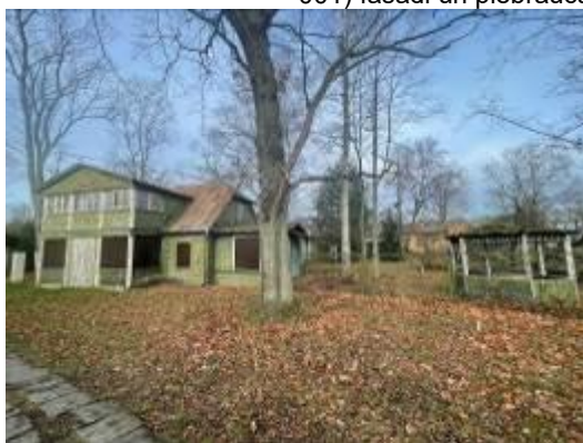
Dzīvojamās mājas (kadastra apzīmējums 1300 010 2018 001) fasāde no Rūdolfa Blaumaņa ielas.
